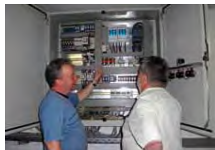
In der Kläranlage Ahnatal informiert Josef Fertig vom Abwasserdezernat des Regierungspräsidiums (r.) über die energietechnische Bewertung der Steuertechnik dieser Kläranlage. Foto: RP
