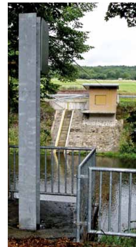
Der Ederpegel Auhammer. Was wie eine Seilbahn aussieht, ist eine Seilkrananlage. Mit ihr kann auch bei Hochwasser der Abfluss gemessen werden.
