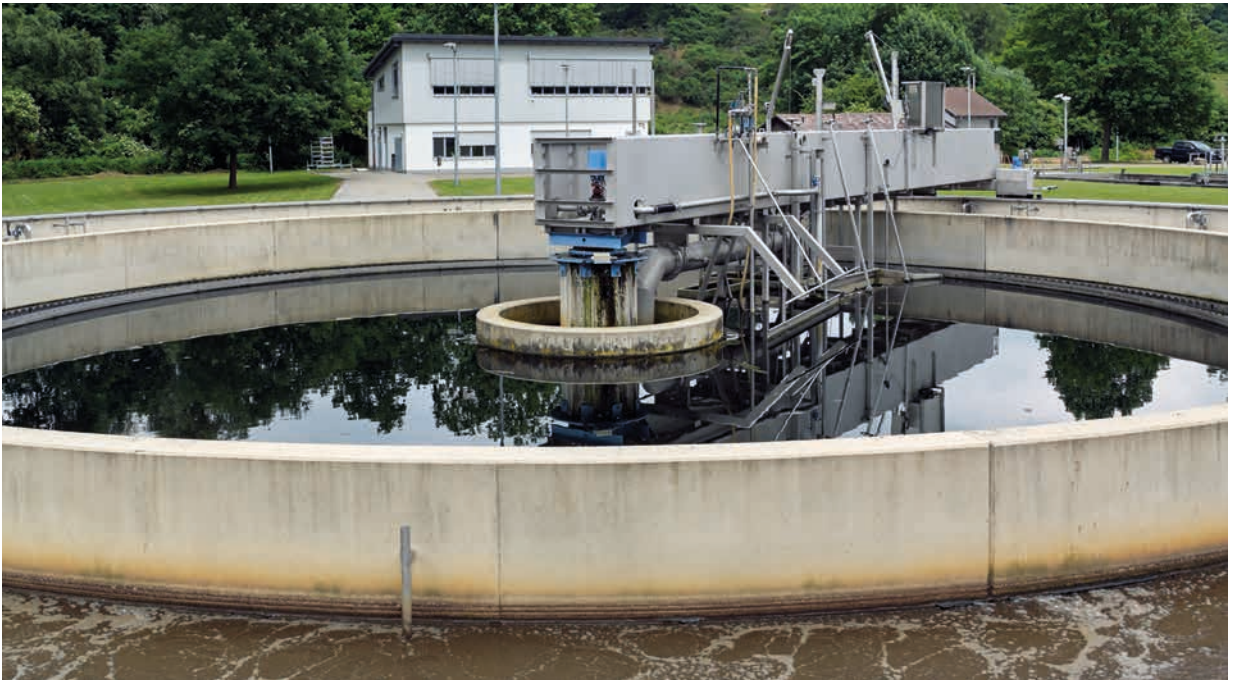
Ein Blick auf die Kläranlage Fritzlar und ein kombiniertes Becken mit außenliegender, biologischer Reinigungsstufe und innenliegender Nachklärung. Foto: Harald Soremski
