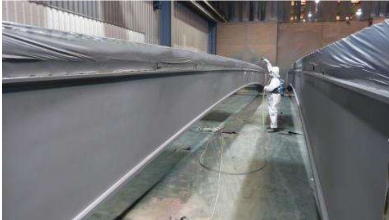
ABBILDUNG 5: FREIE LÜFTUNG BEIM SPRITZEN VON GROßBAUTEILEN
